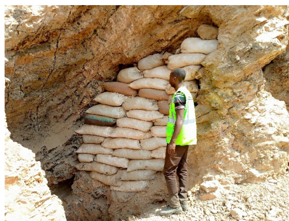
Figure 61. Renforcement d'un pilier d'entrée en surplomb d'une galerie par des sacs de roche stérile.
