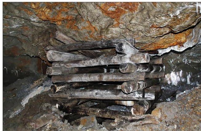
Figure 60. Exemple de pilier en bois installé pour retenir une zone fragile. © baguenaudes.net.
