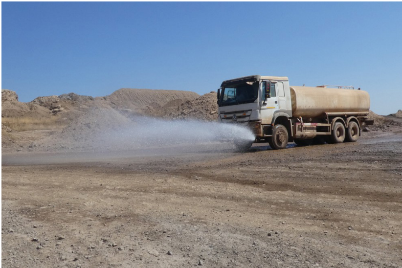
Figure 19 : exemple de réduction des poussières par arrosage des pistes d'accès.
