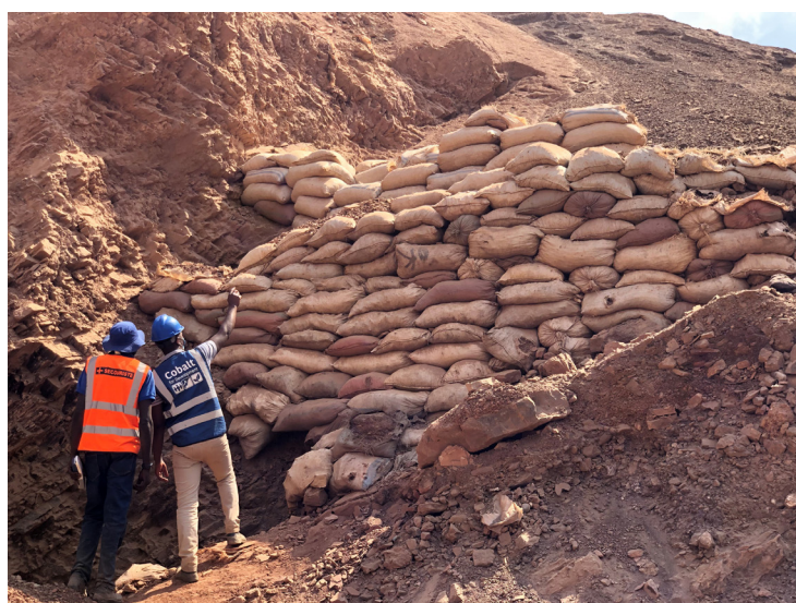
Figure 46. zone de retenue des remblais de stériles faite avec des sacs de remblai, dans une exploitation de cobalt.
