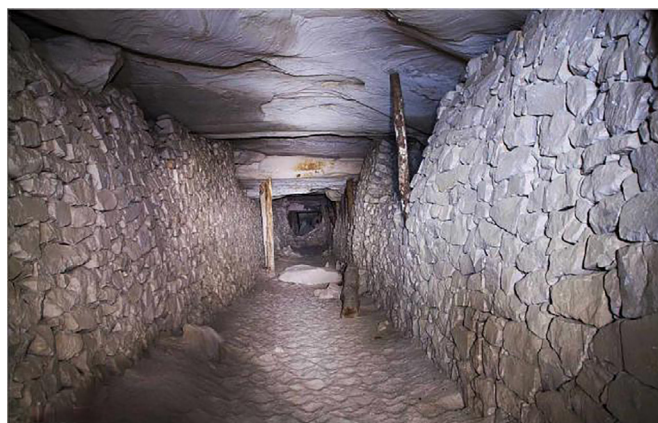
Figure 62. soutènement par bourrage de pierres. © baguenaudes.net.
