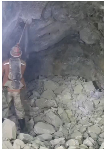
Figure 65. travailleur en train de purger après un tir (exploitation industrielle).
