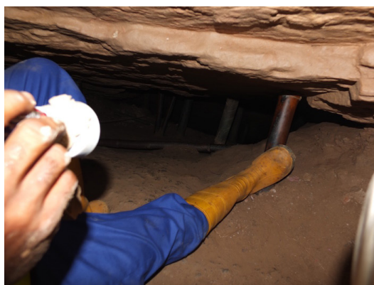
Figure 63. Exemple de renfort horizontal dans une mine artisanale et filonienne d'or.
