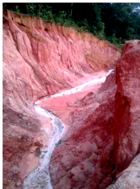
Figure 19. Exemple de figure d'érosion qui pose problème pour la circulation et la réhabilitation. © V. de Billy, 2021.
