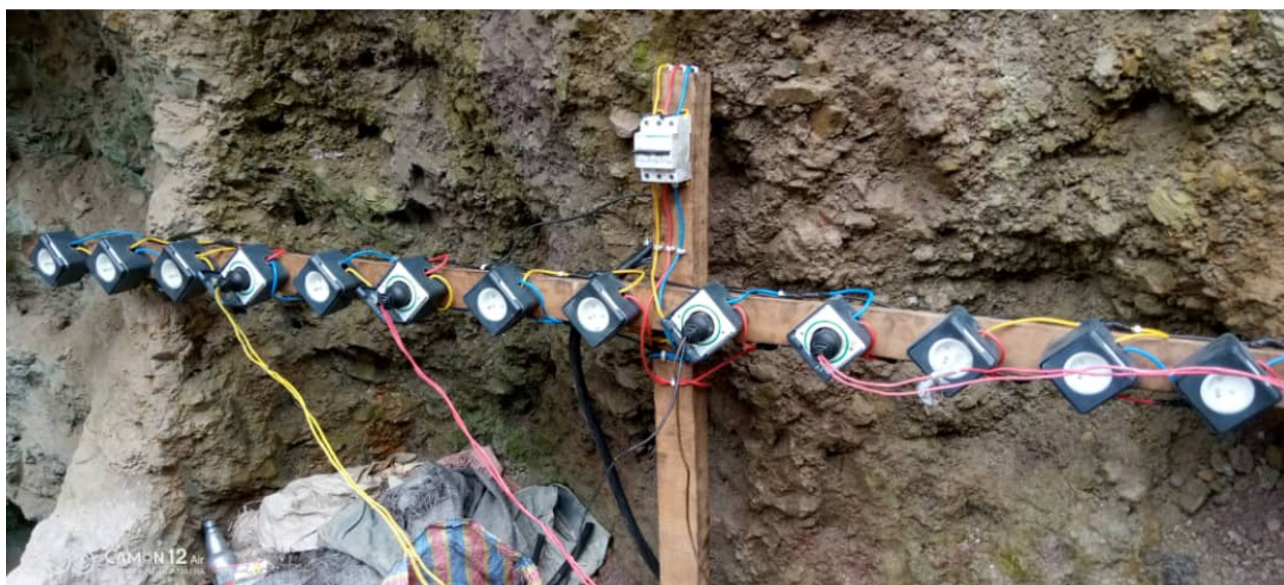
Figure 28 : exemple de montage mieux sécurisé sur les connexions.
